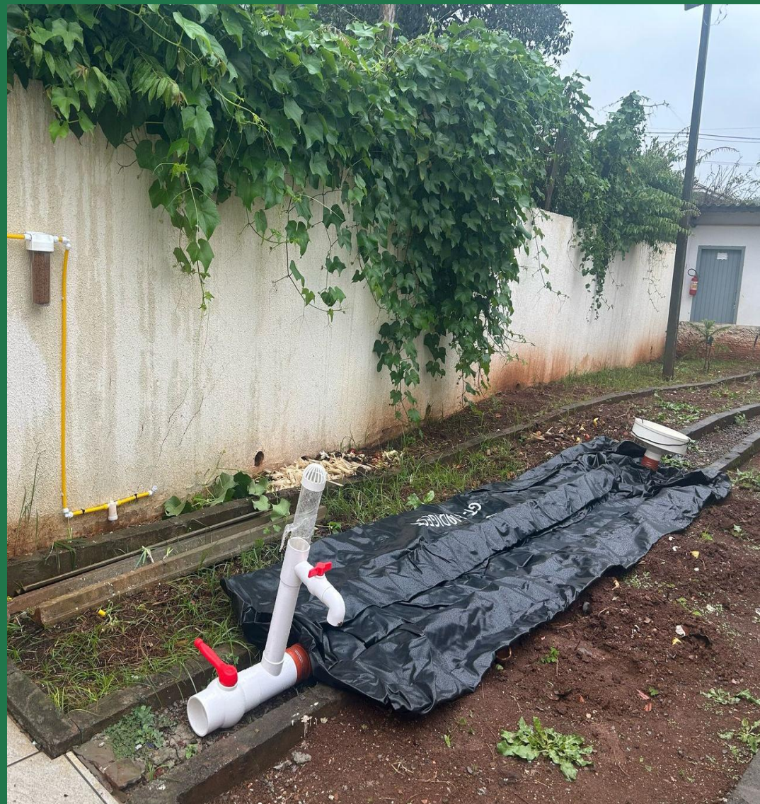
Biodigestor instalado, e fogareiro que utiliza o gás gerado pelo biodigestor
